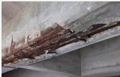
Обнаружение зон, где начинается активная коррозия, включает в себя измерение локализованных отрицательных значений потенциала полуэлементов (т.е. потенциала коррозии). При использовании стержневого электрода
